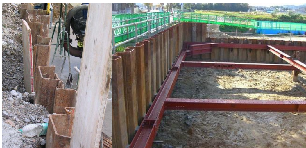
Slika 11: Jeklene zagatnice
