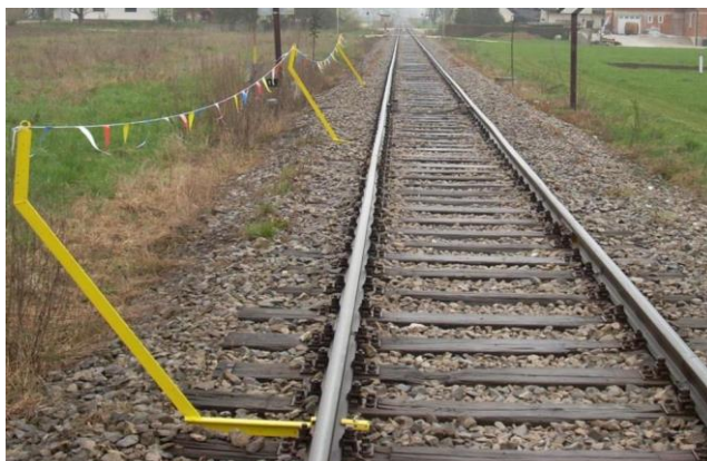
Slika 36: Način namestitve signalne vrvice na kotni profil, ki se pritrdi na nogo tirnice
