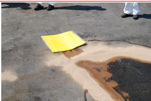
3. Odtočni kanal se pokrije s krpo, ki veže nase nevarno tekočino
